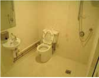
រូបភាព ៥.៤.២.១. គំរូអំពីផ្ការយូកទូតទឹកនៅក្នុងបង្គន់ដែលគ្មានផ្នែកដៃនិងទុយោនៅខាងក្រៅ
