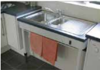
រូបភាព២.៦.៣.១. គំរូអំពីកន្លែងលាងចានដែលសមស្របសម្រាប់ជនមានពិការភាពនិងមានកម្ពស់អាចផ្លាស់ប្តូរបានដែលផ្ទះលាងចានអាចលើកឡើងនិងទម្លាក់ចុះទៅតាមតម្រូវការអ្នកប្រើប្រាស់
