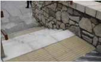
រូបភាព ១.២.៤.៣. គំរូអំពីការរៀបចំឥដ្ឋឆ្នុតៗសម្រាប់ជនមានពិការភាពភ្នែកនៅចំណុចចាប់ផ្តើមនិងចុងបញ្ចប់ នៃជណ្តើរ នៅខាងក្រៅ
