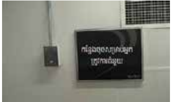
រូបភាព ២.៨.២. គំរូអំពីឧបករណ៍ហៅរកអ្នក ជួយតាមរយៈសំឡេង ទំនាក់ទំនងរបស់អ្នកចតរថយន្ត
