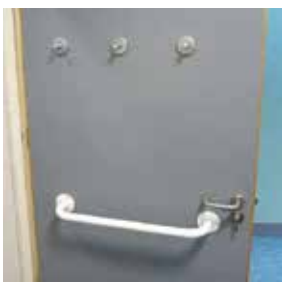
រូបភាព ៥.៧.៥.១. គំរូអំពីធ្នាក់ដៃចាប់ជាប់ទ្វារ
