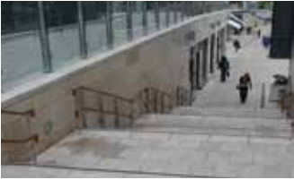
រូបភាព ១.២.៤.២. គំរូអំពីជណ្តើរខាងក្រៅ ផ្ទៃឆ្នុតៗ ចុងខាងលើនិងចុងខាងក្រោមនៃជណ្តើរដែលមាន ពណ៌ឆ្នុតៗទាំងនៅតាមបង្កាន់ដៃនិងកន្លែងសម្រាក
