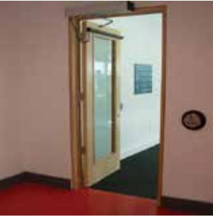
រូបភាព ១.៩.៥.៤.១. គំរូអំពីទ្វារដែលភ្ជាប់ ជាមួយប្រព័ន្ធសញ្ញាការពារអគ្គិភ័យស្វ័យប្រវត្តិ
