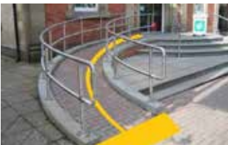
រូបភាព ១.២.១.៣. គំរូអំពីជម្រាលដែលរៀបចំផ្ទៃ បាតសម្រាប់ជនមានពិការភាពភ្នែកអាចប្រើបាន
