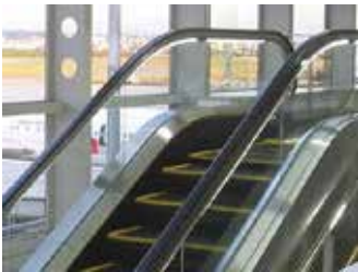
រូបភាព ១.២.៩.១. គំរូអំពីជណ្តើរយន្តដែល បំពាក់ភ្លើងនៅបង្គាន់ដៃចល័ត
