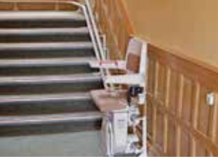
រូបភាព ១.២.៨.១. គំរូអំពីការអីចាប់ភ្ជាប់ទៅនឹងបង្កាន់ដៃជណ្តើរសម្រាប់ចុះឡើង
