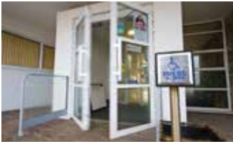
រូបភាព ១.៩.៥.៨.១. ឧទាហរណ៍អំពីទ្វារពីរ សន្លឹកបិទបើកចេញក្រៅចូលក្នុងនៅច្រកទ្វារចូល
