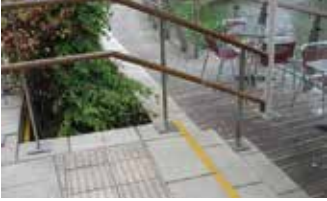
រូបភាព ១.២.៤.១. គំរូអំពីឥដ្ឋឆ្នុតៗ រំលេចពណ៌ចុងខាងលើជណ្តើរនិងបង្កាន់ដៃពីរជាន់ដែលមានពណ៌ផ្ទុយពីផ្ទៃ
